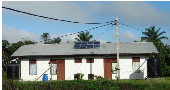
Onderwijzerswoningen Langatabiki met zonnepanelen plus elektriciteit van de dieselgenerator
